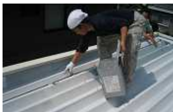
「アドグリーンコート」塗布の様子
