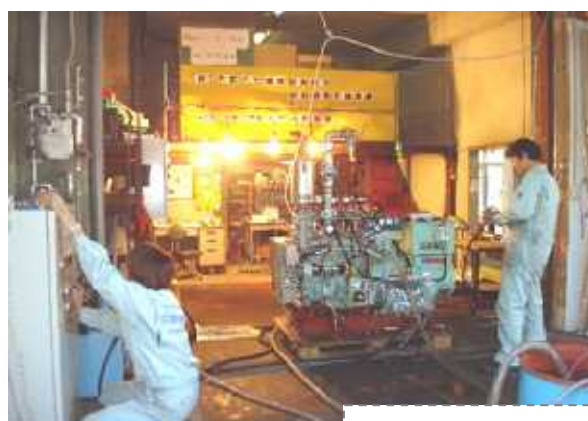
水素エンジン発電機
